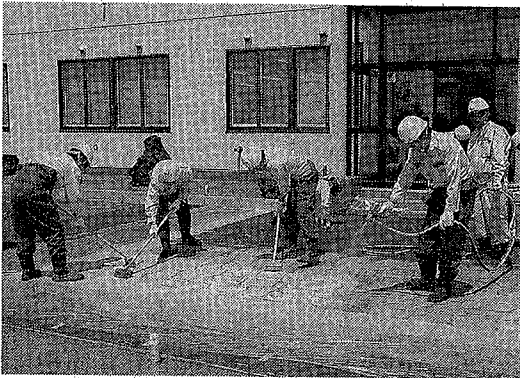
専用のガン Sprey で塗料を吹き付けながら、デッキブラシで塗装膜を均一化
