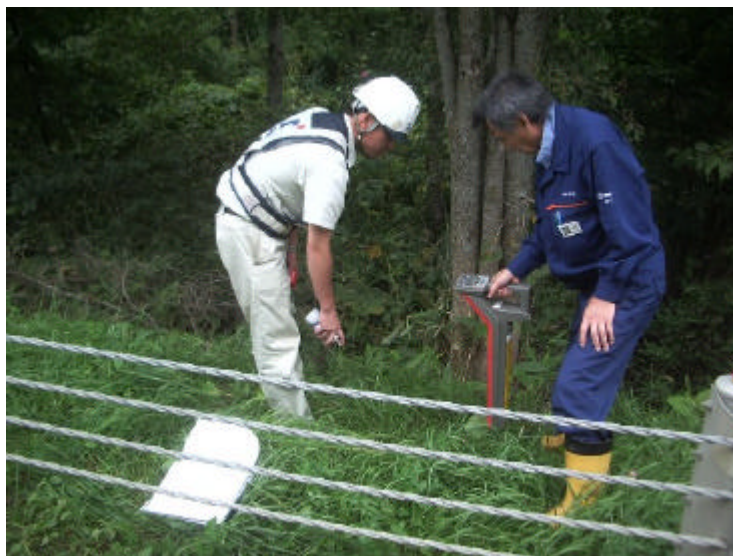
＜地下埋設物の位置確認＞
