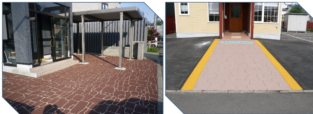
型押し+着色 による施工
