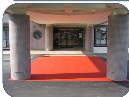
着色のみの施工
