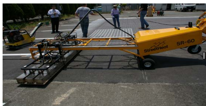
1. 既存アスファルト再加熱
